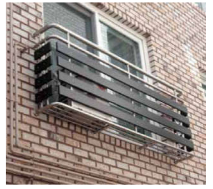
하이보드스텐난간설치(돌출형)-북측면 하이보드스텐난간설치(비돌출형)-동,서,남측면
